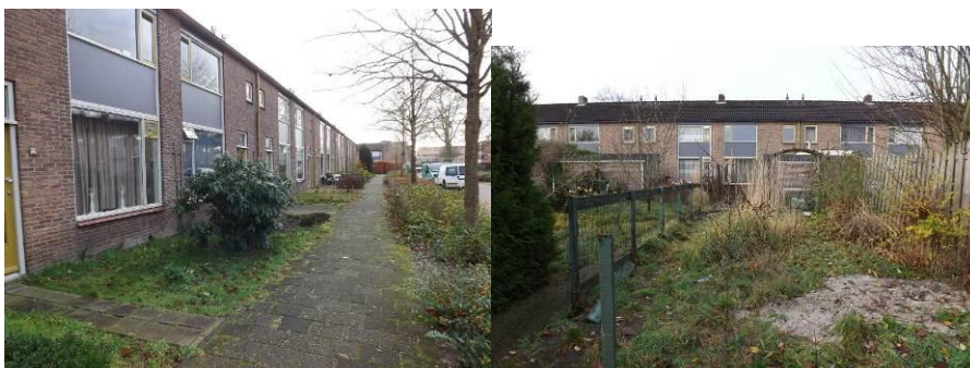
Vos van Steenbergstraat voorzijde(links) en achterzijde (rechts) in Jade C
