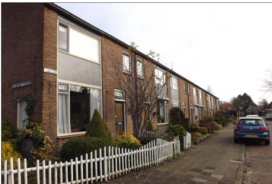
Woningen aan de Hofstraat
