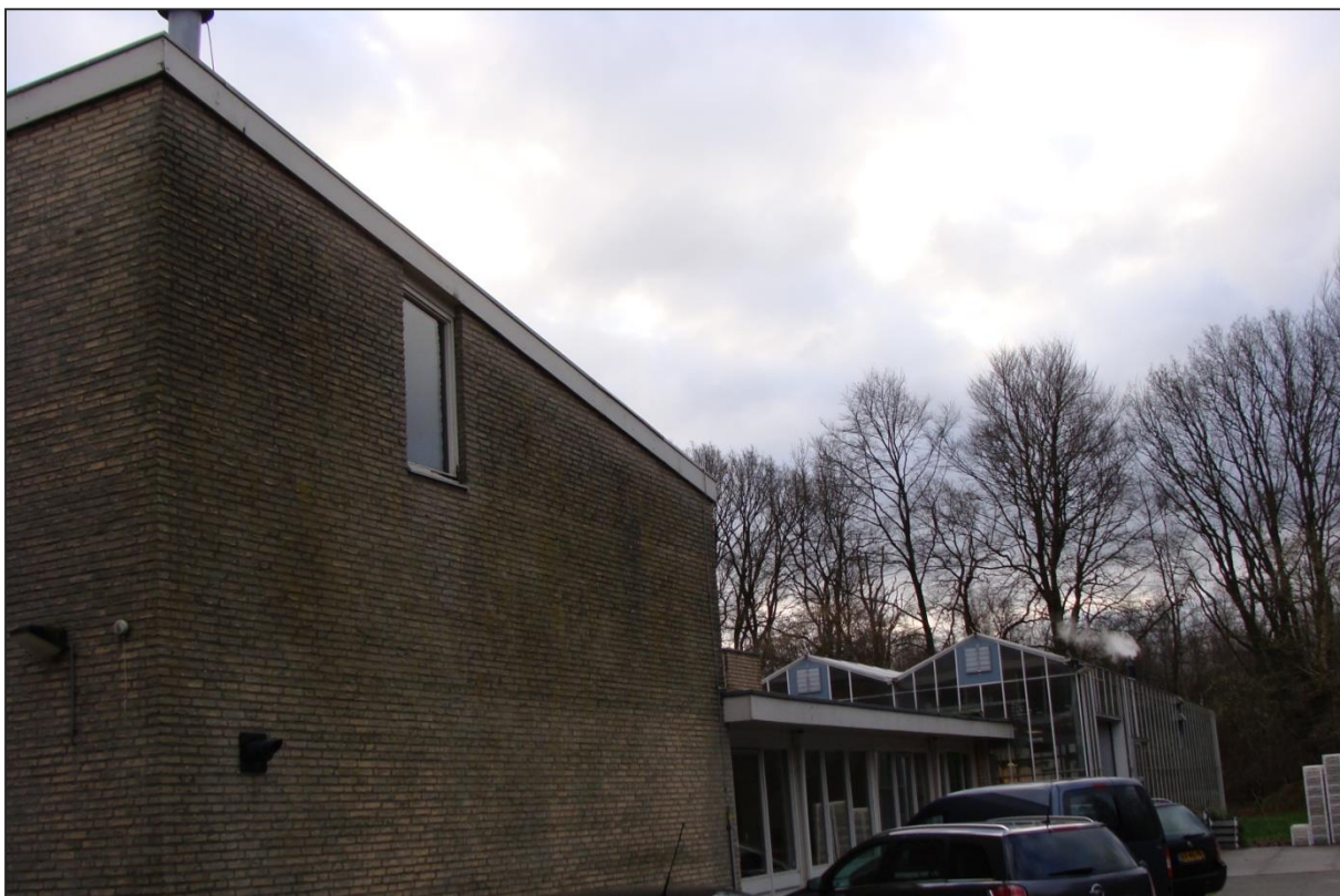
Figuur 5. Impressie van het hoofdgebouw (westzijde), met op de achtergrond de aangebouwde kas.
