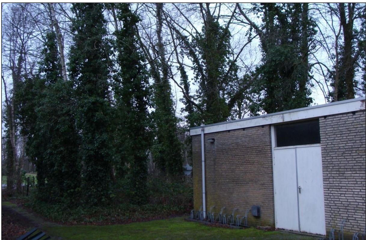
Figuur 7. Impressie van het schuurtje (het elektrahuisje staat erachter en is op deze foto niet zichtbaar), met op de achtergrond een plantsoen met opgaande bomen.
