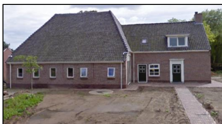
'Seubring' zijgevel na verbouwing
