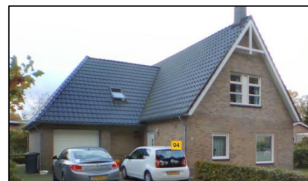
Beilen – Esweg 94 (nieuwbouw na sloop)
