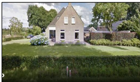
'Seubring' voorgevel na verbouwing
