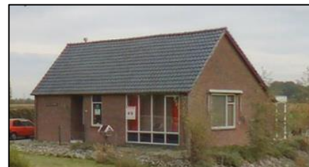
Bovensmilde – Hoofdweg 25 (nieuwbouw na sloop)
