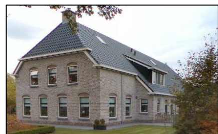
Bovensmilde – Kanaalweg 177 (nieuwbouw na sloop)
