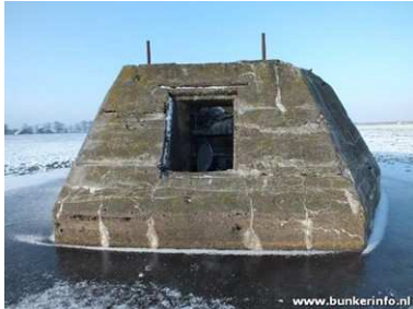
Figuur 15. Betonnen peiler van de radarschotel radiopeil en radarstation Marder , Ter Arlo (bron: https://www.bunkerinfo.nl/2013/01/fumg-marder.html )
