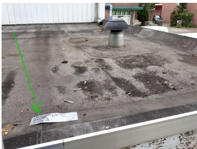
Foto 1: MM13, bitumineuze dakbedekking
