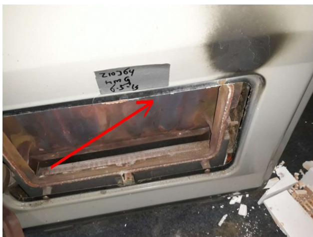
Foto 1: MM9, koordafdichting gaskachel keuken
