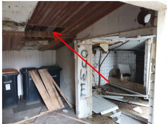
Foto 4: Situering golfplaten dak schuur
