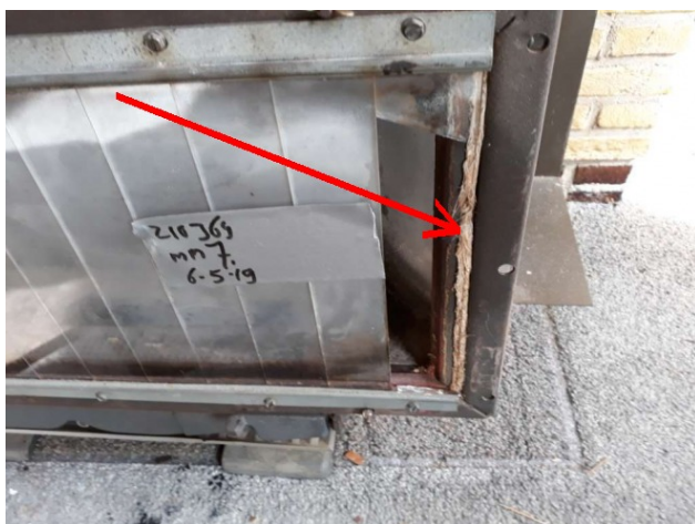
Foto 1: MM7, koordafdichting gaskachel
