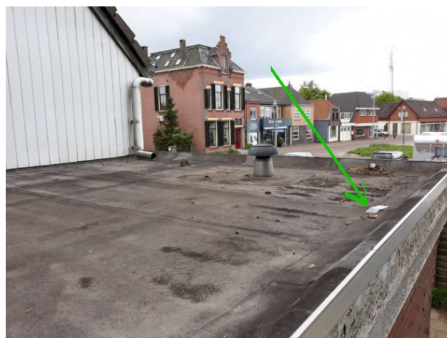
Foto 2: Situering MM13, bitumineuze dakbedekking
