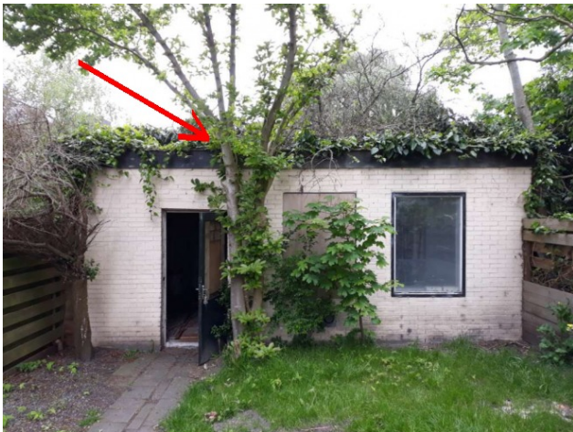
Foto 3: Situering golfplaten dak schuur
