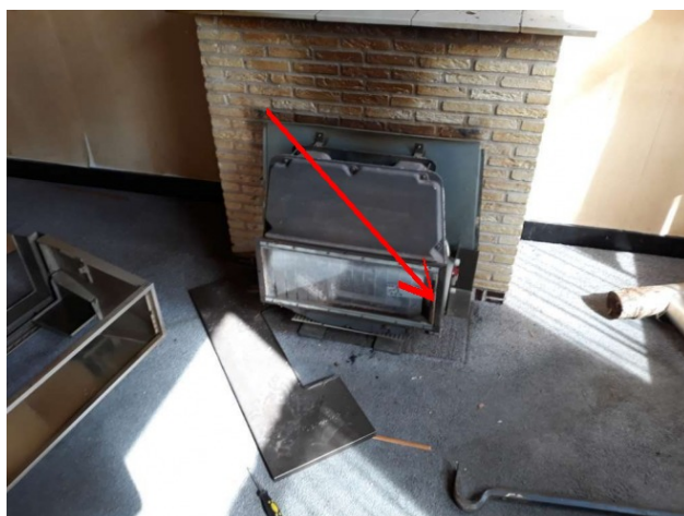
Foto 2: Situering MM7, koordafdichting gaskachel
