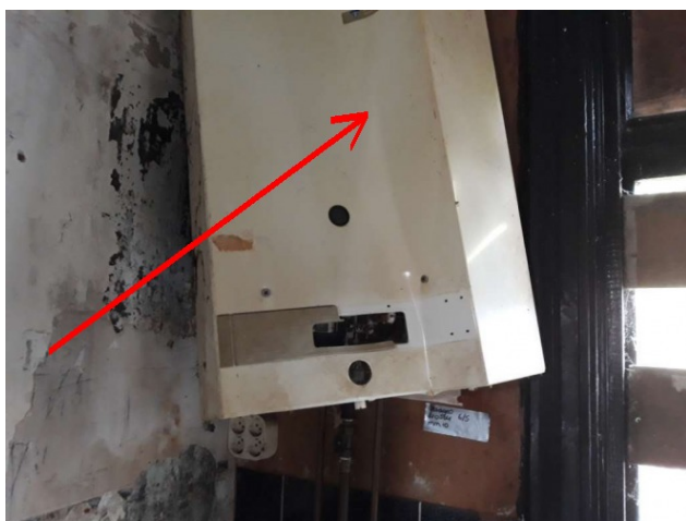
Foto 1: Geiser Merk Junker, type WR325
