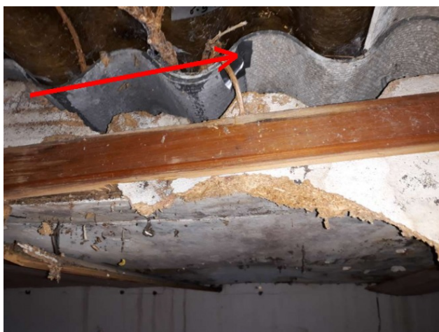
Foto 1: MM12, golfplaten dak schuur
