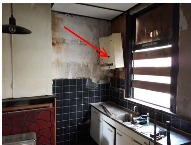
Foto 2: Situering geiser Merk Junker, type WR325
