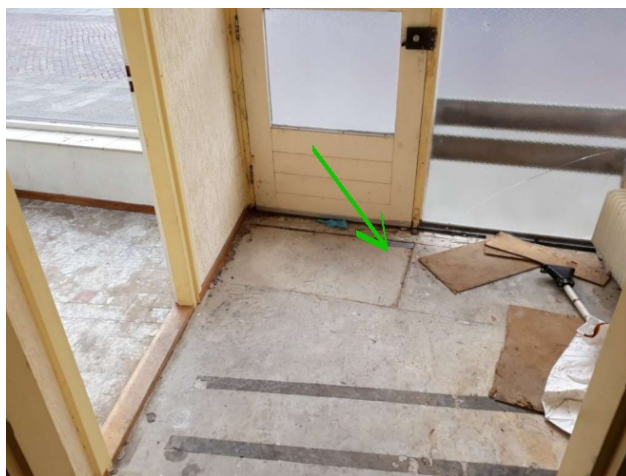
Foto 2: Situering MM1, plaat toegangsluik kruipruimte
