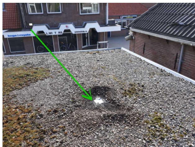
Foto 2: Situering MM3, dakbedekking
