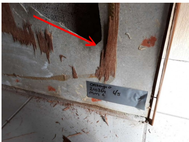
Foto 1: MM6, vlakke platen aftimmering boven gaskachel
