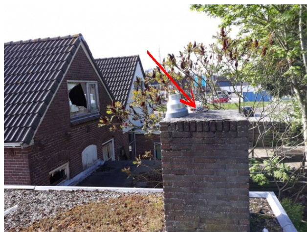
Foto 2: Situering MM4 buis in schoorsteen
