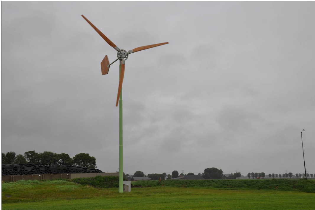
Figuur 4. Een windturbine waarvan de as horizontaal is georiënteerd.
