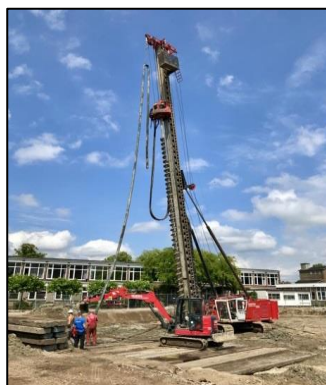
Heien van de funderingspalen
