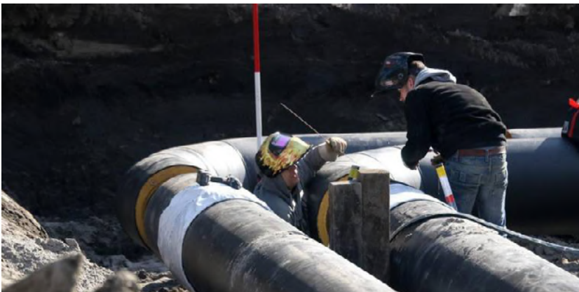
Aanleg warmtenet Bron: Dagblad van het Noorden
