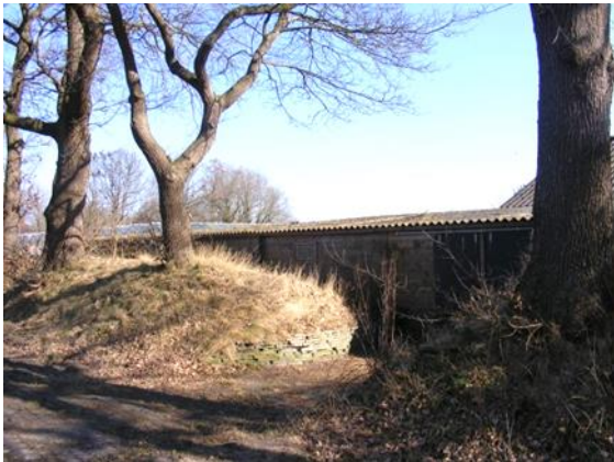
Te herstellen houtwal
