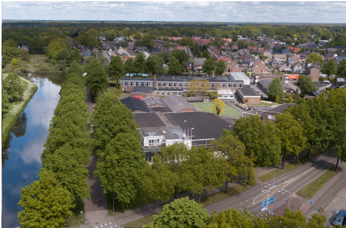
Figuur 2.1 Voormalige Oostland locatie met daarachter de huidige school (bron: Wind Design + Build).
