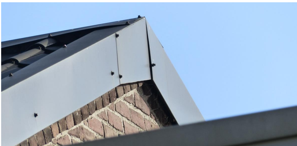
Foto 5 Nok van een van de puntdaken die ruimte biedt voor vleermuizen.
