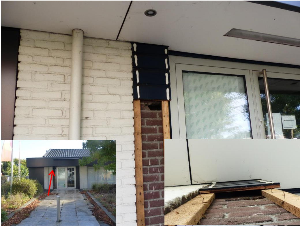
Foto 6 Losse planken naast de hoofdingang bieden ruimte voor vleermuizen. Wederom vrij lage invliegopening, maar gebruik als invliegopening is niet uit te sluiten.
