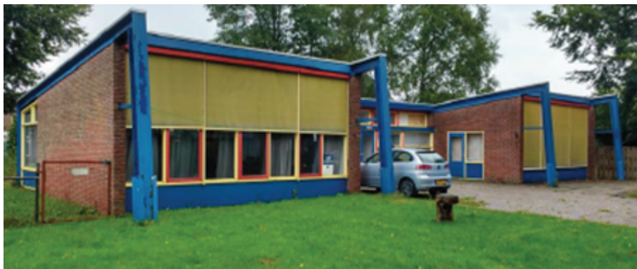
Bestaande (voormalige) kleuterschool
