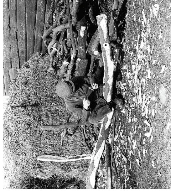
Het handmatig bewerken van houten stammen voor de bouw van onder andere hekwerken. Serie van Beelen 1944 (bron: coll. NL).
