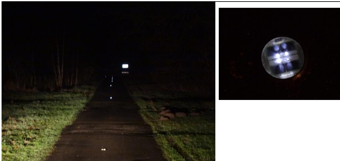
Figuur 0.3 Actieve markering t.b.v. fietspad, fietspad richting terhorst vanaf Beilen
