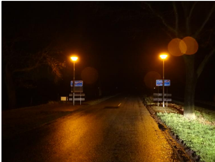
Figuur 6.2 Voorbeeld 'kom indicatie' verlichting, Zwiggelte
