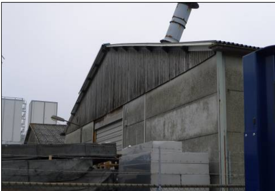
Figuur 4.2.4: Foto voor vleermuizen geschikte gevelbetimmering aan een bedrijfsgebouw in het plangebied.
