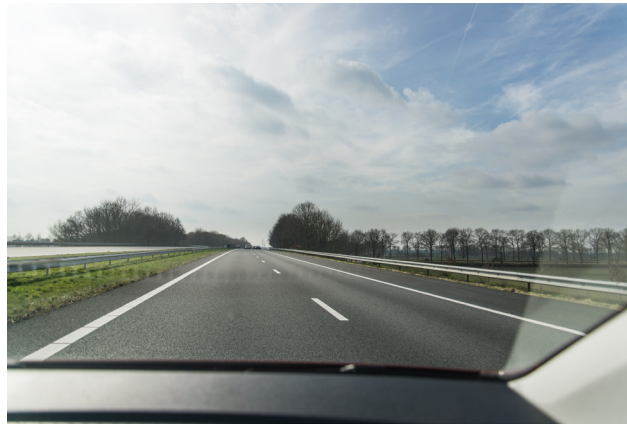
2. zicht op veld 1 vanaf aanlanding viaduct A28
