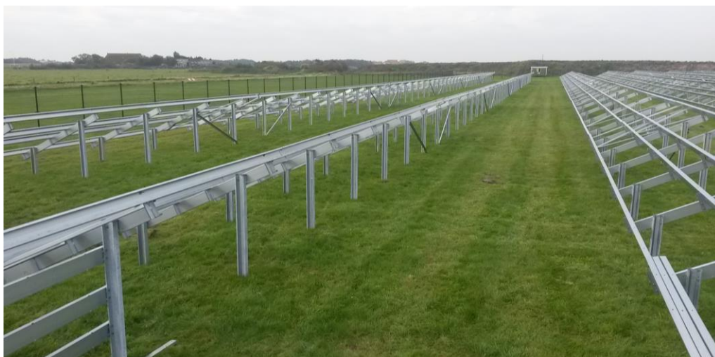
Figuur 4.2: Foto ter illustratie van installatieframe voor bevestiging zonnepanelen
