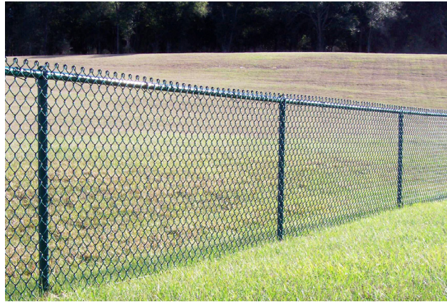
hekwerk met harmonicagaas in RAL 7016 (antracietgrijs)
