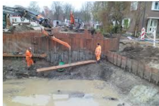
Aanbrengen van de walbeschoeiing
