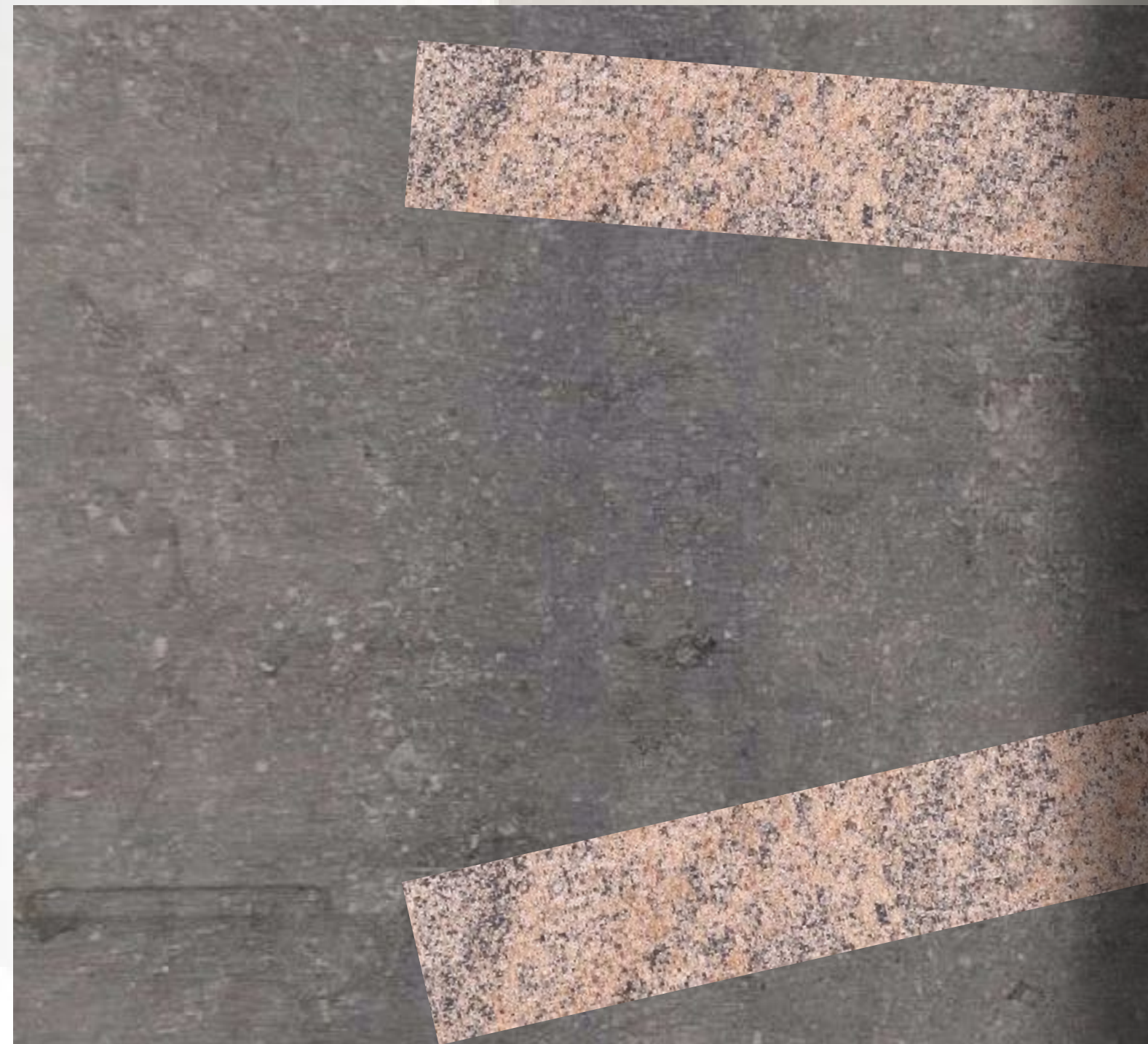
Hardsteen vloer hal bestaand i.c.m. graniet
