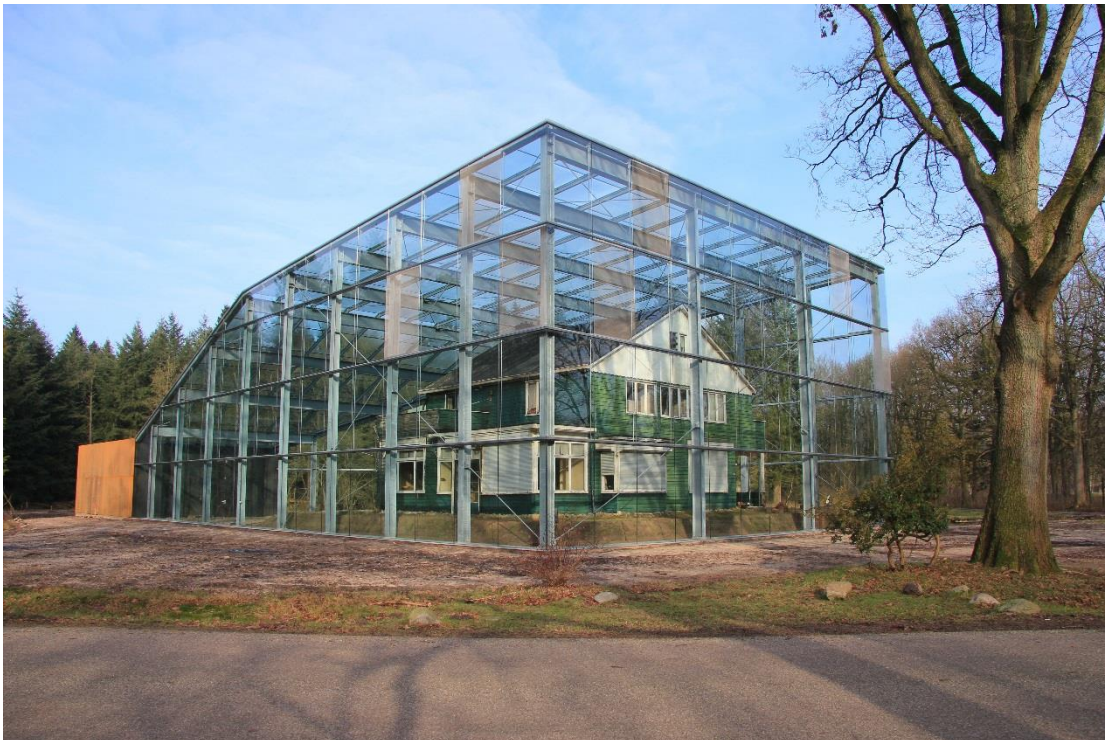
Woning kampcommandant na renovatie en realisatie overkapping
