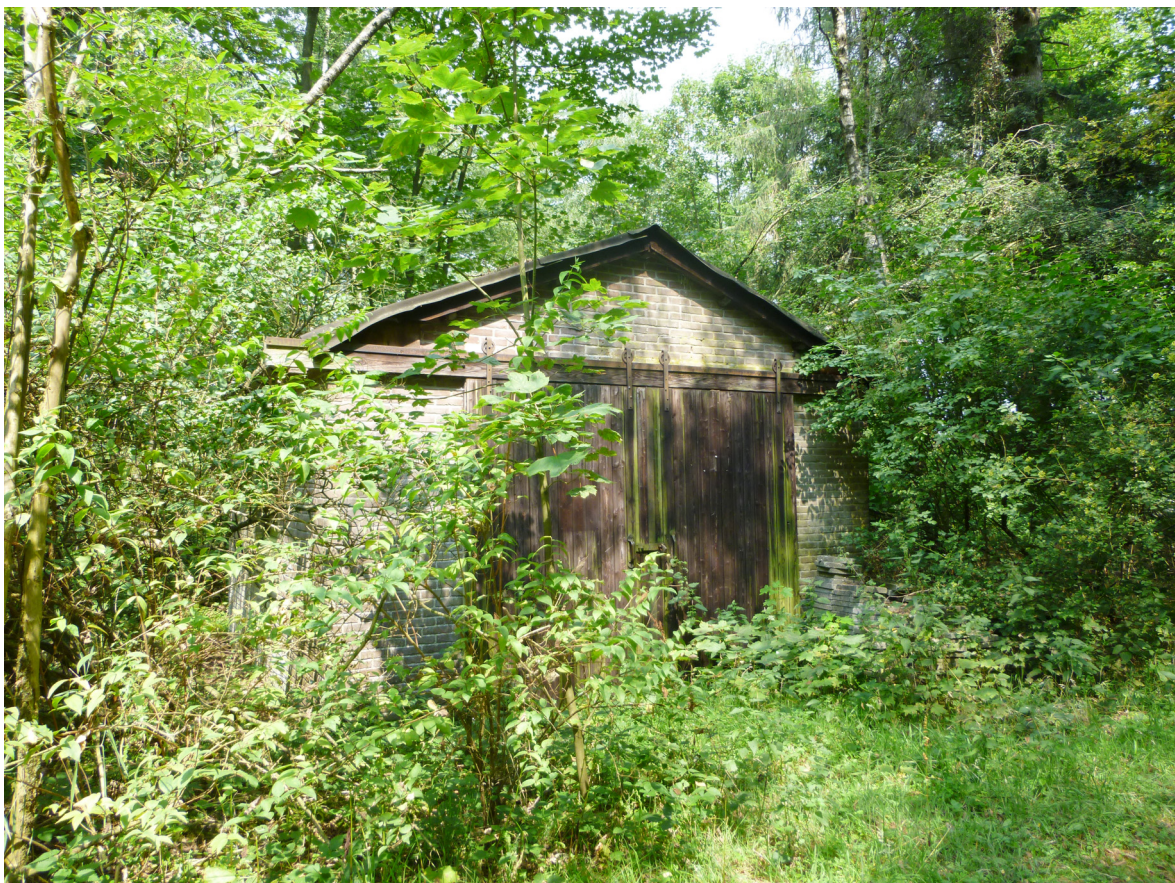
Figuur 8. Gebouwtje in het Heidelager.
