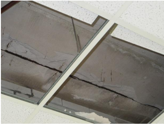
Blootliggende wapening in de langs richting van de gasbetonplaat.
