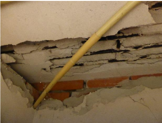
Geconstateerde gebreken gasbeton dakplaat leraren toilet.
