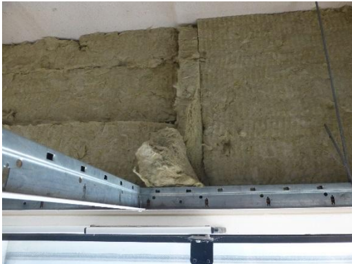
Isolatie aan de binnenzijde tegen de gevel
