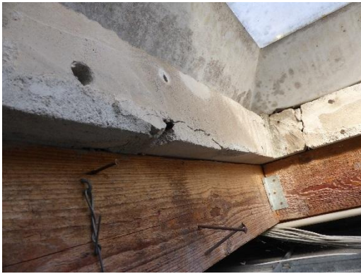
Geconstateerde gebreken t.p.v. de lichtkoepels
