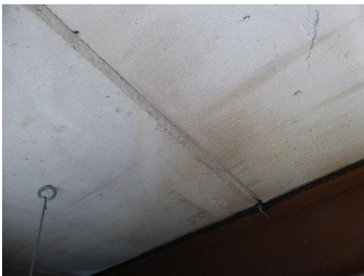
Geconstateerde gebreken gasbeton dakplaat lokaal.
