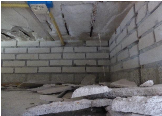
Geconstateerde gebreken gasbeton dakplaat lokalen.
