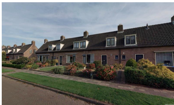
Vervangende nieuwbouw Verlengde Havenstraat Beilen
