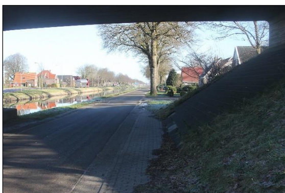
Figuur 3.6. Onder viaduct door N381.
