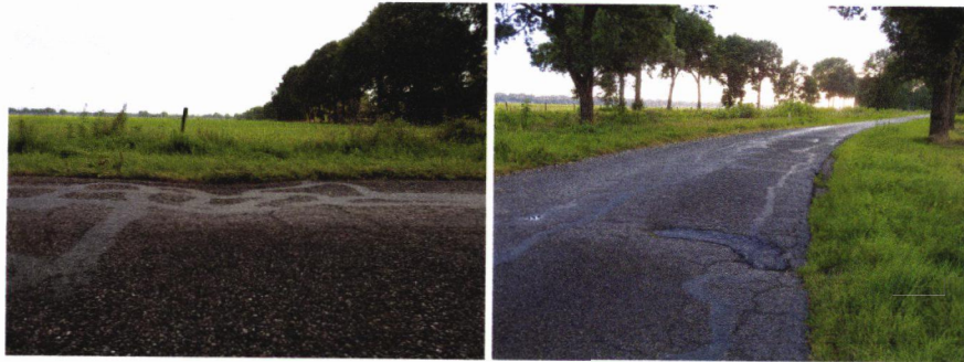
Plakwerk , waardoor het wegdek niet vlak is. Met name voor fietsers is dit vervelend
