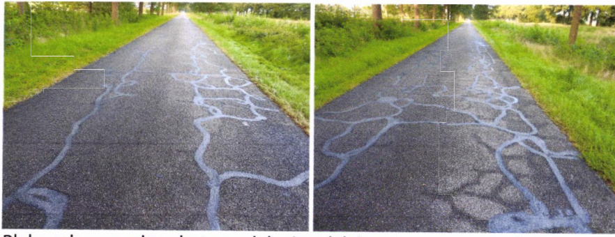
Plakwerk , waardoor het wegdek niet vlak is. Met name voor fietsers is dit vervelend
