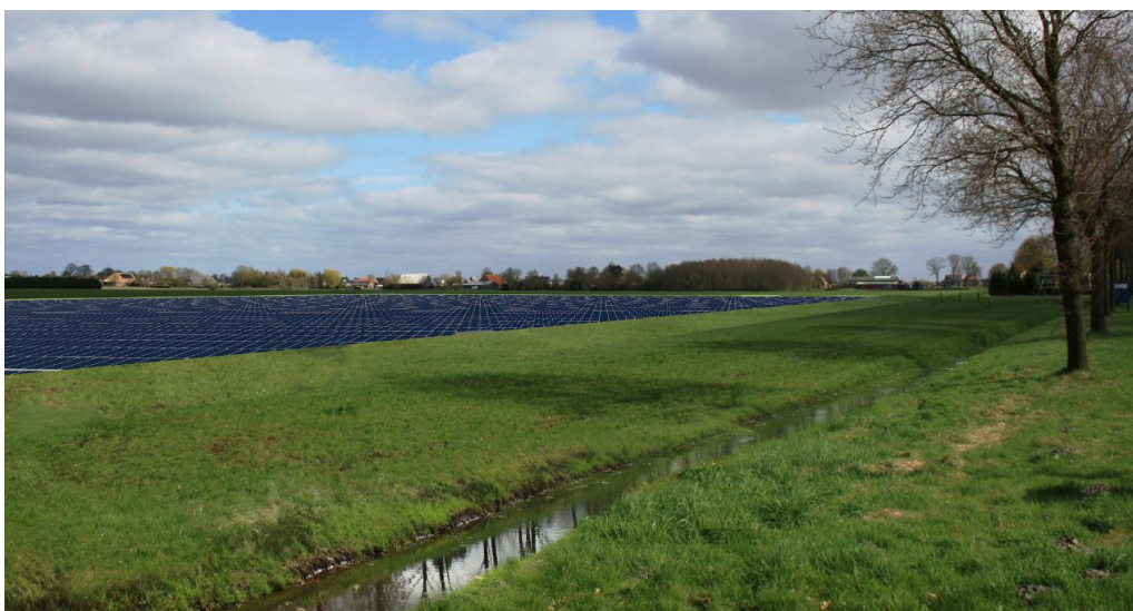
Foto 5: situatie met zonnepanelen en grondwal naast Leemdijk 15
