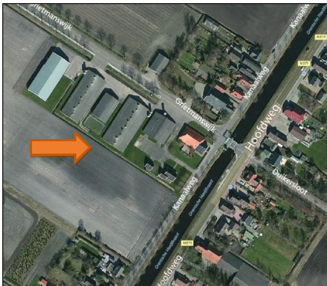
Figuur 2 | Bestaande bedrijfsperceel met bebouwing
