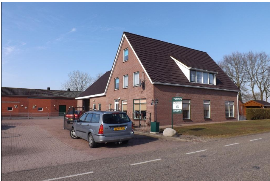
De voormalige bedrijfswoning
