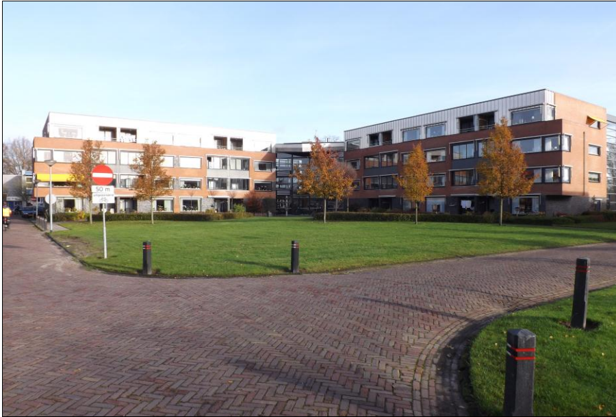
Aangrenzende bebouwing (valt buiten het plangebied)
