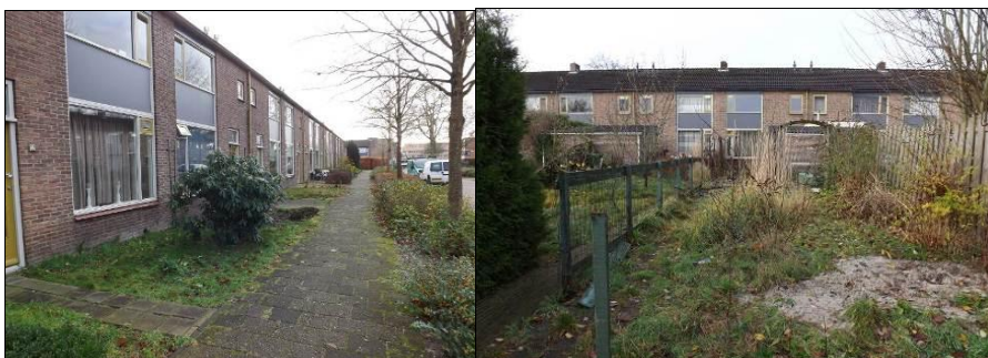
Vos van Steenbergenstraat voorzijde (links) en achterzijde (rechts) in Jade C
