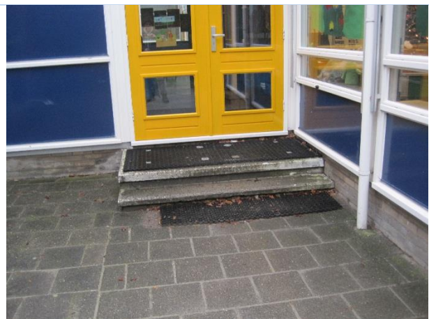
Toegankelijkheid van de school voldoet niet aan MIVA eisen (maximale dorpelhoogte 15 mm)
