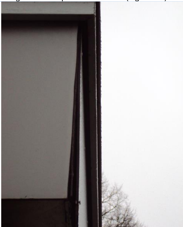
Volkern boeiboorden ongeventileerd (ondeskundig) aangebracht tegen multiplex ondergrond daardoor inwendige condensvorming en aantasten van achterliggende constructies, beplating komt ten gevolge van aangetaste achterliggende constructies plaatselijk los (veiligheidsrisico/ risico gevolgschade)
