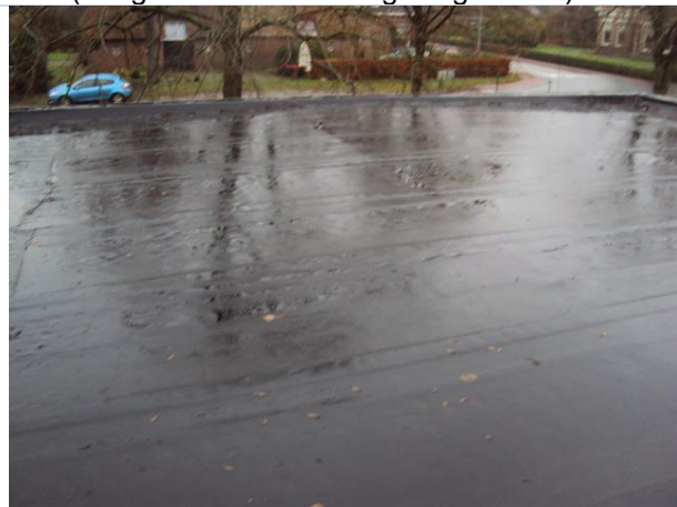
Dakranden en dakbedekking in het vlak van dakvlak F ondeskundig aangebracht, veel naden los, plooi- en blaasvorming, risico lekkage/ gevolgschade
