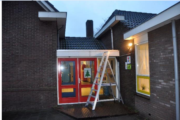
Opstand ter plaatse van entree
