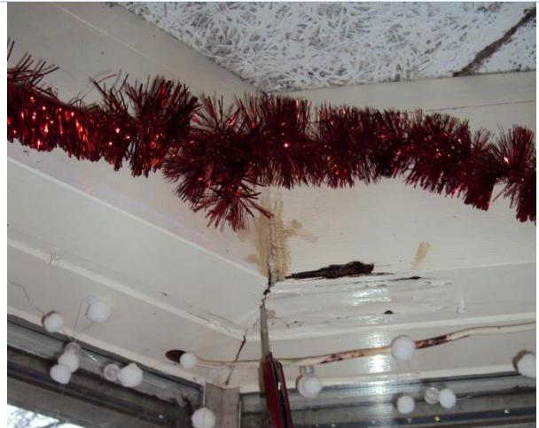
Aangetast houtwerk dakconstructies
