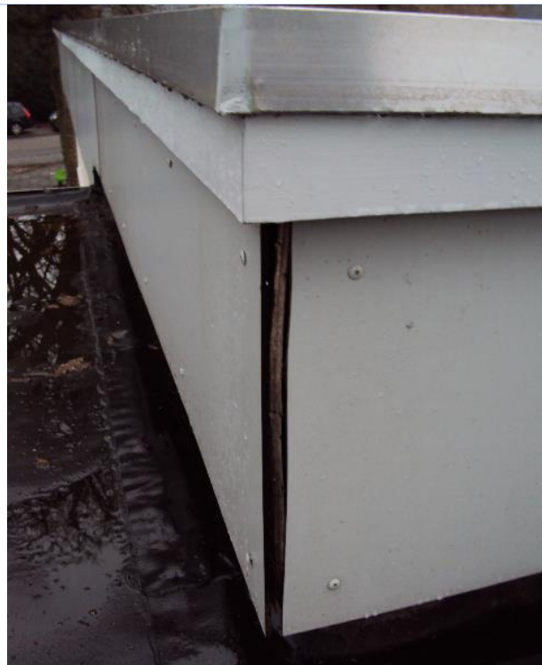
Volkern boeiboorden ongeventileerd (ondeskundig) aangebracht tegen multiplex ondergrond daardoor inwendige condensvorming en aantasten van achterliggende constructies, beplating komt ten gevolge van aangetaste achterliggende constructies plaatselijk los (veiligheidsrisico/ risico gevolgschade)
