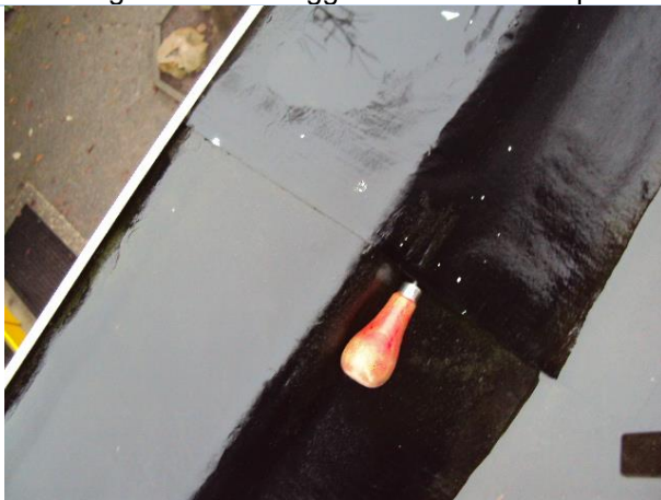
Dakranden en dakbedekking in het vlak van dakvlak F ondeskundig aangebracht, veel naden los, plooi- en blaasvorming, risico lekkage/ gevolgschade
