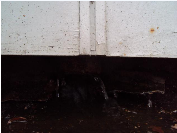
Aangetaste multiplex boeiboorden (algemeen)
