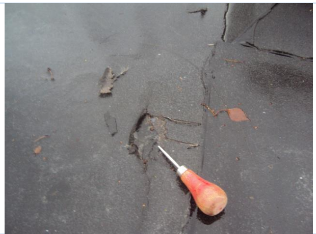
Onjuiste materiaaltoepassing bij overlaagd deel
