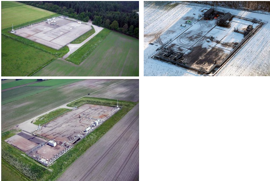
Figuur 2.2: Voorbeelden van bestaande gasproductielocaties
